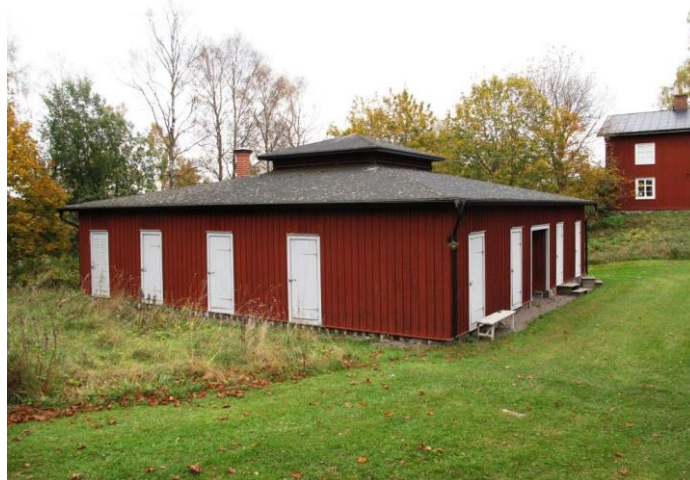
Uthus med dass och förråd, för både Gråbo och Korpkullen.
